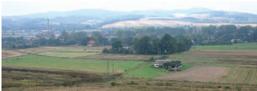
Fig. 8. Zapadlisko Kudowy, widok od strony ul. Słonecznej w Kudowie Zdroju
