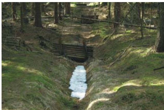
Fot. 7. Zabezpieczenia przeciwoerozyjne na szlaku zrywkowym na północnych stokach Narożnika. Widoczny brak śladów erozyjnej działalności wód stokowych (fot. K. Parzóch).
