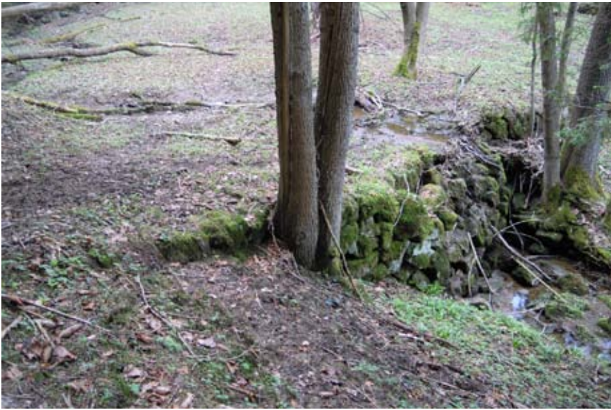
Fot. 20. Rozległa strefa akumulacji materiału mineralno-organicznego na zapleczu nieoczyszczonej zapory przeciwpowodziowej w Januszowie, aktualnie niszczonej przez erozję (fot. A. Latocha).
