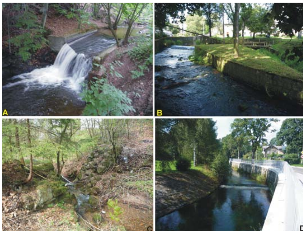
Fot. 26. Budowle piętrzące na potokach w Górach Stołowych: A – zniszczony jaz stały na Dańczówce, poniżej progu przegłębienie eworsyjne dna; B – jaz stały na Kamiennym Potoku w Szczytnie, po prawej widoczny kanał młynówki; C – zniszczona zapora przeciwrumowiskowa na Kudowskim Potoku; D – sztuczny próg w korycie Kamiennego Potoku (brzeg obudowany murem oporowym oraz okładziną kamienną) (fot. M. Witek).
