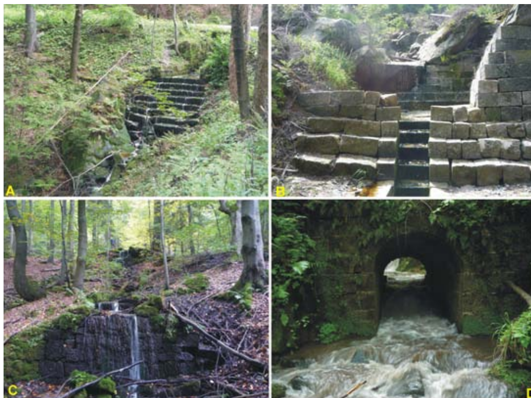
Fot. 25. Sztuczne kaskady na potokach Gór Stołowych: A, B – Żidovka, C – Rogoziniec i D – Pośna (fot. M. Witek).
